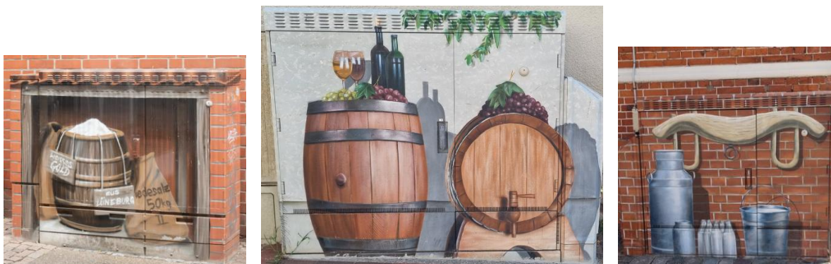
Abbildung 14: Gut getarnte Elektrokästen: li in Lüneburg (AUS), mi&re in Wismar (Norddeutschlandreise UH)
